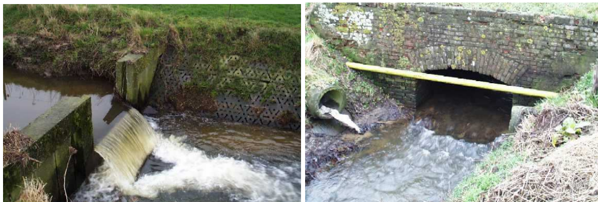
Figuur 1. Voorbeeld van één van de landbouwstuwen en bodemplaten in de Kasteelbeek ( www.vismigratie.be ).
