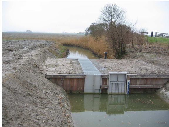
Figuur 2. De Wit-vispassage gecombineerd met een terugslagklep.
