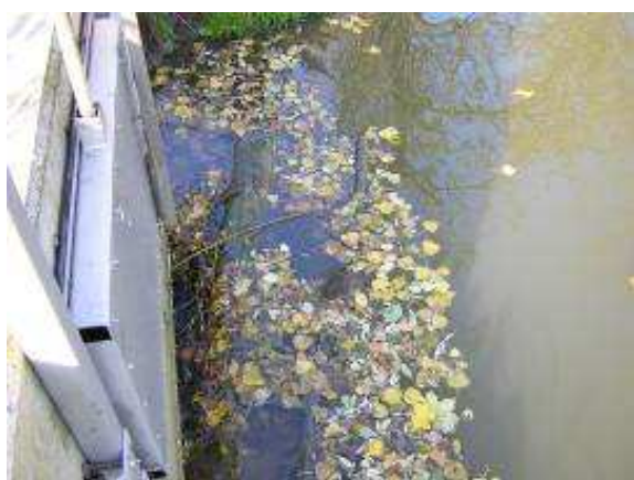
Foto 4 & 5: Verstopping van de inlaatconstructie van de visnevengeul met boomstammen, takken en bladeren aan de Ter Biestmolen in de Zwalm (Links: stroomopwaarts aanzicht, Rechts: stroomafwaarts aanzicht).
