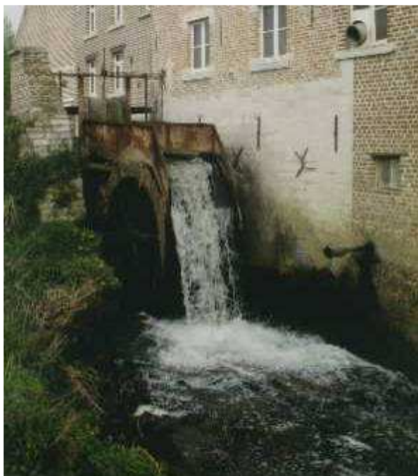
Foto 1: Dalemse molen met bovenslagrad in de Velve (Foto: www.vismigratie.be ).
