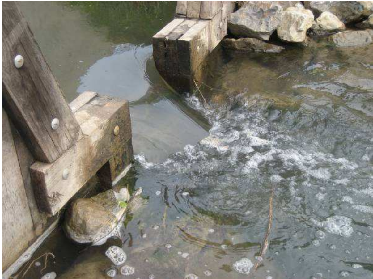
Foto 7: Een vrije inlaatconstructie zonder luchtbelgordijnen, met een verval van 15 cm en een doorzweemhoogte van 14 cm, is passeerbaar voor de meeste vissoorten met goede zwemcapaciteiten die nu in de Velpe voorkomen.
