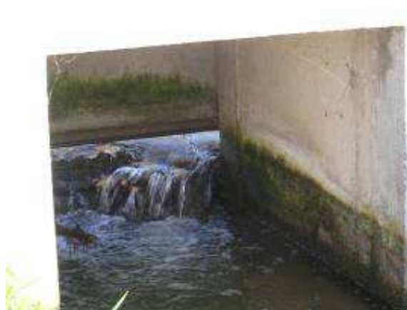
Foto 4 & 5: Verstopping van de inlaatconstructie van de visnevengeul met boomstammen, takken en bladeren aan de Ter Biestmolen in de Zwalm (Links: stroomopwaarts aanzicht, Rechts: stroomafwaarts aanzicht).
