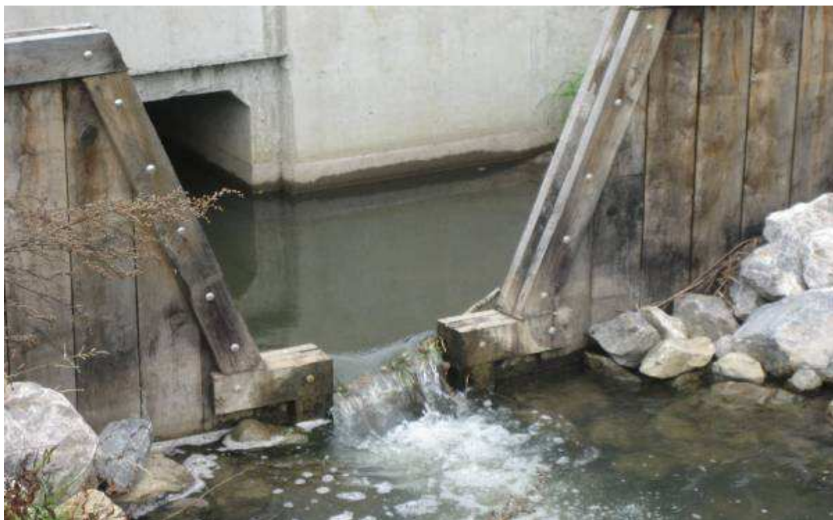
Foto 3: De nauwe verticale sleuf in de houten inlaatconstructie van de vistrap is gevoelig voor verstopping door o.a. takken met luchtkamers tot gevolg (Foto: Werner Mennen).
