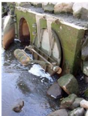
Figuur 7: Tweede type kattenluik. Mitigator Fish passage device (Nehalem Marine). De onderzijde van de klep scharniert op de hoofdklep en vlotters regelen de opening van het onderste deel. Een tandwielstelsel zorgt ervoor dat dit onderste deel geblokkeerd wordt in de open positie tijdens eb en het eerste deel van vloed. Tijdens de tweede helft van de vloed duwt het opkomende water de vlotters omhoog en wordt de blokkering van het onderste deel opgeheven, waardoor de klep volledig sluit.
