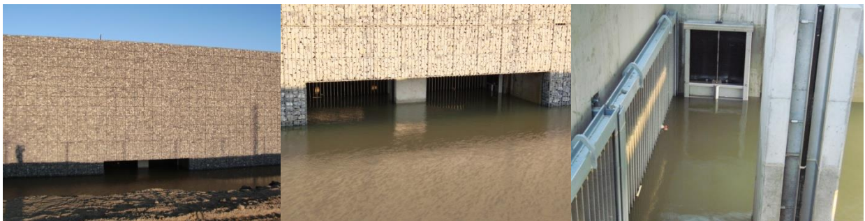
Figuur 4: Foto's van het pompgemaal landinwaarts. Foto links: de monumentale schanskorfwand met onderaan centraal de instroomopening. Foto midden: de instroomopening van het water. Foto rechts: achter de schanskorfwand, links het rooster en frontaal het luik dat de vismigratiebuis afsluit.
