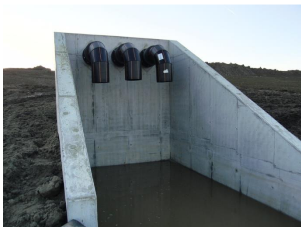
Figuur 5: het buitendijks kunstwerk met de drie persleidingen. De uitwatering van de 'vismigratiebuis' zit op de bodem onder het huidige waterpeil en is niet zichtbaar.
