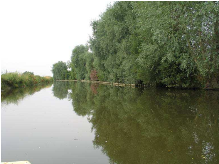
Foto 3. Zicht op de IJzer te Beveren, ter hoogte van de linkeroever (rechts in beeld) werd in 2005 een vooroever aangelegd
