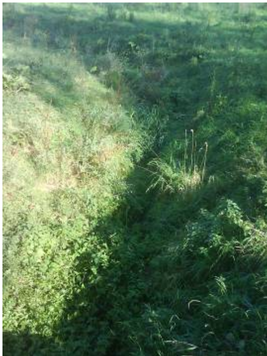
Figuur 4.21: Door een permanent sluiten van de inlaatschuif wordt de visnevengeul overwoekerd door planten.
