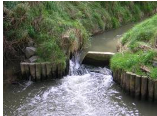
Figuur 2.8: Strekdam aan de uitstroomopening van de nevengeul.
