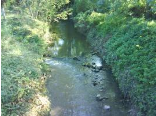
Figuur 4.19: Bij een volledig geopende schuif van de visnevengeul t.h.v. de Bostmolen is er een goede lokstroom merkbaar in de Zwalm.
