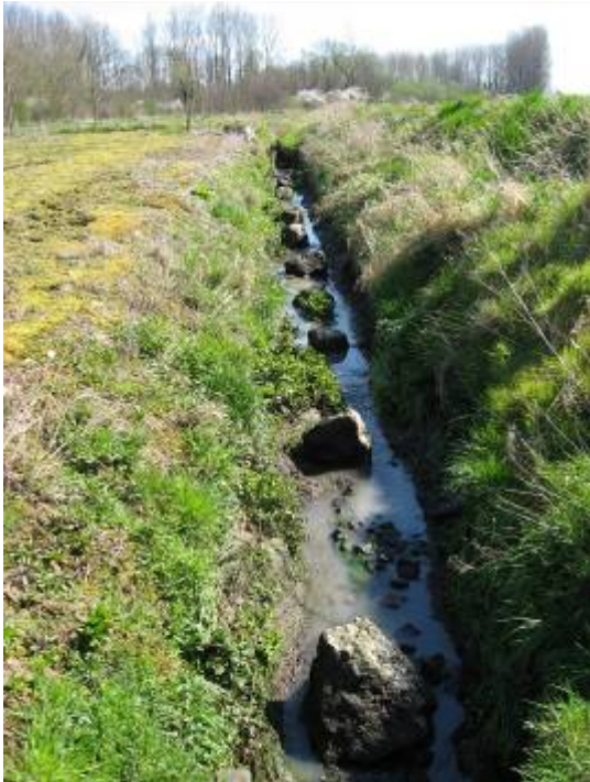
Figuur 2.5: Grote stenen in de nevengeul moeten de stroomsnelheid breken en diversifiëren.
