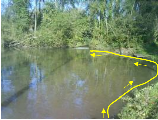
Figuur 4.16: Voorstel tot verlenging van de nevengeul langsheen de rechteroever van de nevengeul.
