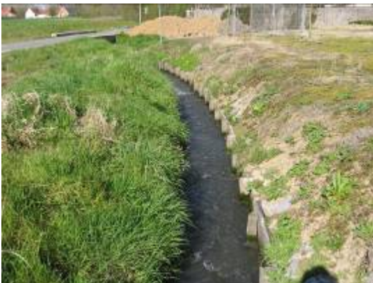
Figuur 2.6: Oeververdediging met damplanken en stortstenen.
