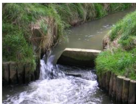
Figuur 4.2: Uitlaat van de visnevengeul. Enkel de V-vormige uitsparing in de strekdam is watervoerend. Het verval, de turbulente zone en een deel van de lokstroom zijn duidelijk zichtbaar.
