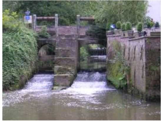
Figuur 2.4: Oude stuw t.h.v. de Ter Biestmolen met op de achtergrond de regelbare klepstuw.
