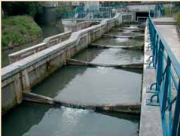
Foto 9: Luchtkamers onder de drempels en minieme doorzwemzone en doorzwemhoogte bij vistrap Bergévest
