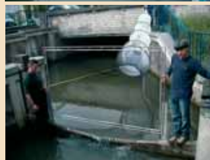
Foto 6: Frame van vistrapfuij in geleiders plaatsen
