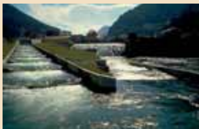
Foto 10: Voorbeeld van een V-vormige bekkenvistrap met ideale doorzwemzone en doorzwemhoogte (vistrap op de Neste - Frankrijk). (Photo Larinier)
