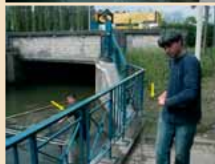
Foto 7: Opspannen vistrapfuij met staalkabel
