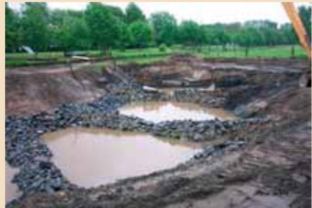
Foto 2.2: Ruwe, uit stortsteen opgebouwde, bekkenscheidende wanden met vertical slot.
