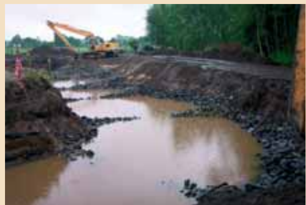
Foto 2.3: Eindfase bouw V-vormige bekkenpassage met vertical slot.
