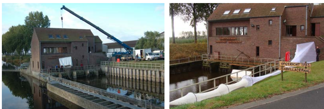
Figuur 4: Installatie van de gemaal fuik voor de grote vijzel (links) en de gemaal fuik voor de kleine vijzel op de oever (rechts).
