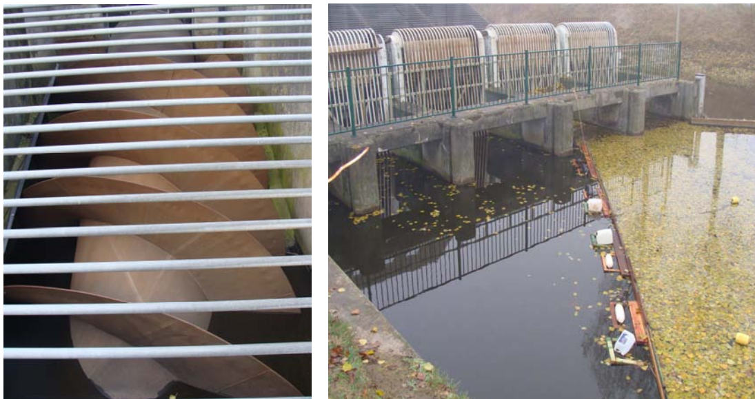
Figuur 3: Grote vijzel (links) en drijfconstructie om drijvend materiaal af te leiden naar pompen waar geen gemaalruik achter zit.
