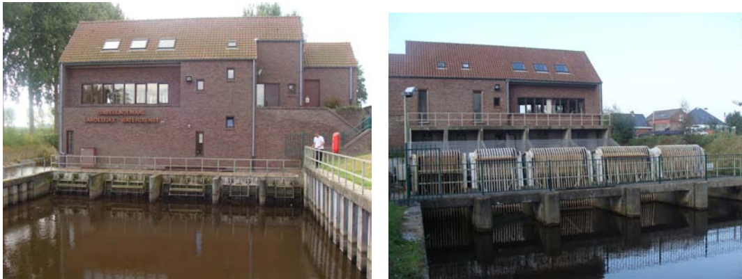
Figuur 2: Uitstroomzijde van het Isabellagemaal met terugslagkleppen (links) en stroomopwaartse inlaten met vuilroosters (rechts).
